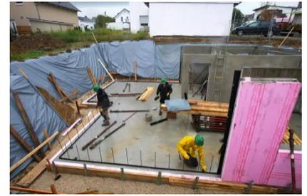
Der Lastfall Bodenfeuchte und an der Wand ablaufendes Wasser liegt vor, wenn sowohl der Baugrund bis zu einer ausreichenden Tiefe unterhalb der Kellerfundamentplatte wie auch das Verfüllmaterial der Arbeitsräume aus stark durchlässigen Böden bestehen, oder eine dauerhaft funktionsfähige Drainage nach DIN 4095 als Zusatzleistung ausgeführt wird. Die Unterkante Kellerfundamentplatte muss mindestens 50 cm oberhalb des Bemessungswasserstandes liegen.
